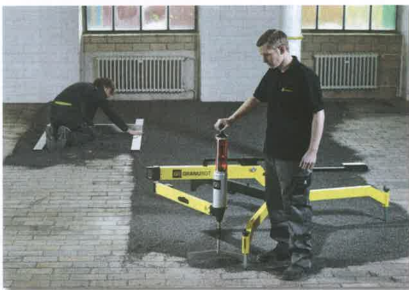
Eine Arbeitserleichterung, die ins Auge fällt: Mit dem Granubot, einer angesehenen Innovation, wird das Auffüllen von Flächen einfacher. Fotos: Granubot
